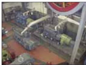
Der Maschinenraum - das Herz der Dachstein-Seilbahn! Im Frühjahr werden die Dieselaggregate durch Elektromotoren ersetzt. Rund 200.000 Liter Dieselverbrauch pro Jahr nach Abschluss aller Arbeiten sind Vergangenheit. (Foto: Planai-Bahnen)
