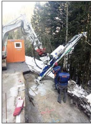
Hangstabilisierung im Bereich zwischen Kehre 1 und 2 fertig gestellt und fachgerecht saniert. Die Hangstabilisierung erfolgte mittels 4 bzw. 6 Meter langen Stahl-Erdankern, die mit Zement im Untergrund verfestigt wurden. Wir danken allen für ihr Verständnis und ihre Nachsicht, dass es zu kurzzeitigen Behinderungen gekommen ist!
