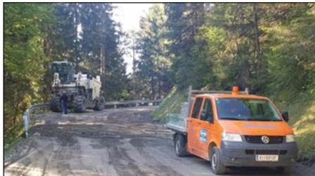
re 2 generalsaniert. Hierbei wurde auf bereits gut bewährte Technik der Zementstabilisierung für den Unterbau verwendet. Die Asphalt-Deckschicht wurde mit zwei Asphaltiermaschinen gleichzeitig und fugenfrei aufgebracht. Zusätzlich wurde ein Steinschlagnetz bei der Kehre 1 angebracht, um den sehr steilen, teilweise losen Hang in diesem Bereich zu sichern. Wir bedanken uns bei den ausführenden Firmen für die termingerechte Fertigstellung.
