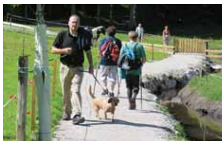
Wegverbreiterung im Bild die Ramsau Allee – weitere Wege wurden im Vorberg und am Kulmberg bereits saniert. Es wird ständig weitergebaut und saniert.
