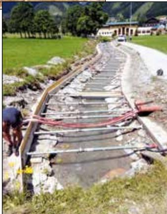
Bachüberführung neu hergestellt. Teile des Fundaments mussten neu betoniert werden und das Brückenniveau wurde um ca. 50 cm angehoben.
