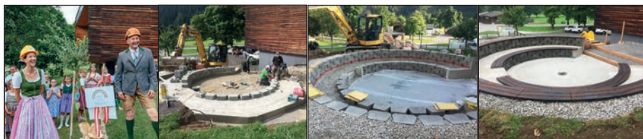
Unser „Klassenzimmer im Freien“ ist fast fertig und es schaut schon richtig spitze aus!
